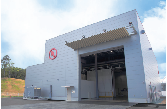
組立エリアおよび建屋
