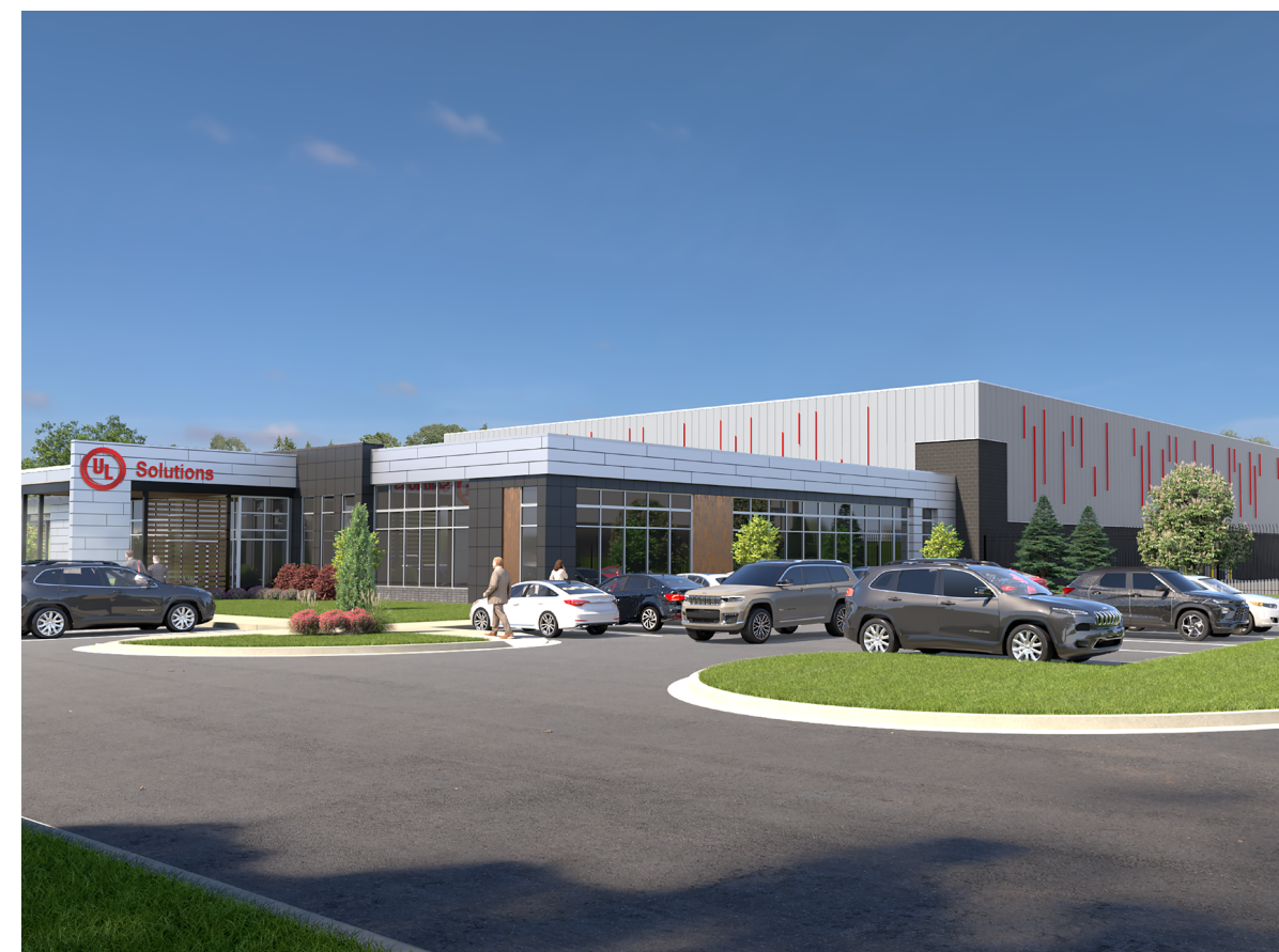
北米先端バッテリー試験所
